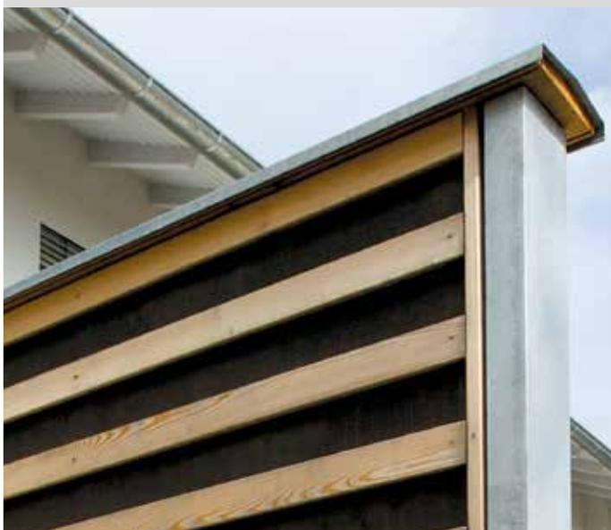
Ausführung mit Stahlpfosten
