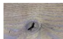
Astausbrüche und raue Stellen an Ästen
