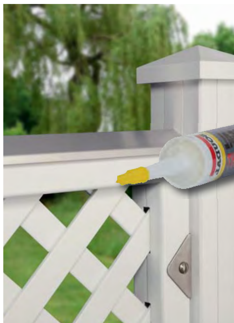
Designaufsatz Alu mit MS-Polymer-Kleber (1398) befestigen.
