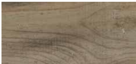
Stockflecken und leichter Schimmelbefall
