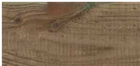
Raue Stellen auf der Holzoberfläche
