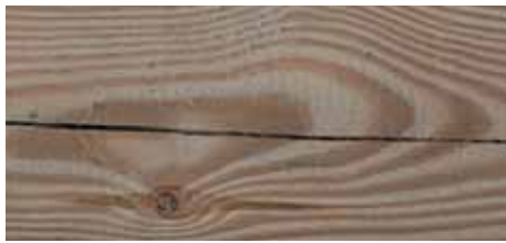
Spannungsrisse durch die Holz Trocknung
