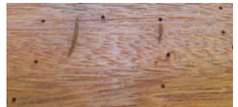
„Pinholes“ bei überseeischen Harthölzern
