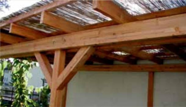
Das Leimholz eignet sich für Pergolen und zur Überdachung von Sitzplätzen. Durch seine natürliche Art erhält die Lärche eine gräuliche Patina. Die Lärche besitzt eine hohe Festigkeit und eine gute Widerstandsfähigkeit für den Aussenbereich. Sehr geeignet für Konstruktionen, die der Witterung ausgesetzt sind.
