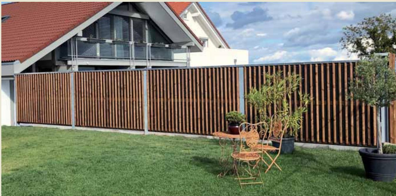
Lärmschutzwand aus stabilen Elementen zwischen einbetonierten H-Eisenträger versetzt, vorgefertigte Elemente: Rückseite Nut/Federschalung und absorbierende Seite Halblatten 5,5 cm (auf Abstand) in verschiedenen Oberflächenstrukturen, dazwischen kaschierte Mineral-Schallschluckplatte. Pfostenabstand bis 400 cm, Schalldämmung ca. 33 dB
