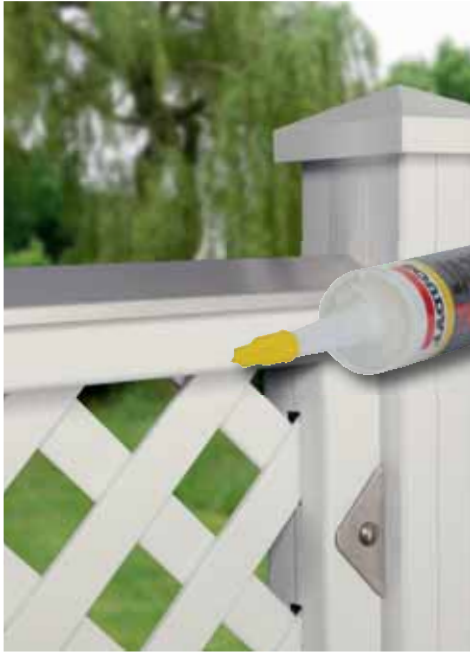
Designaufsatz Alu mit MS-Polymer-Kleber (1398) befestigen.
