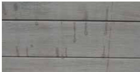
Fleckenbildung durch von Regen angelöste Partikel
