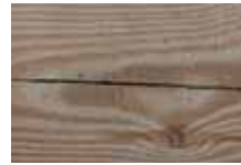
Spannungsrisse durch die Holz-trocknung
