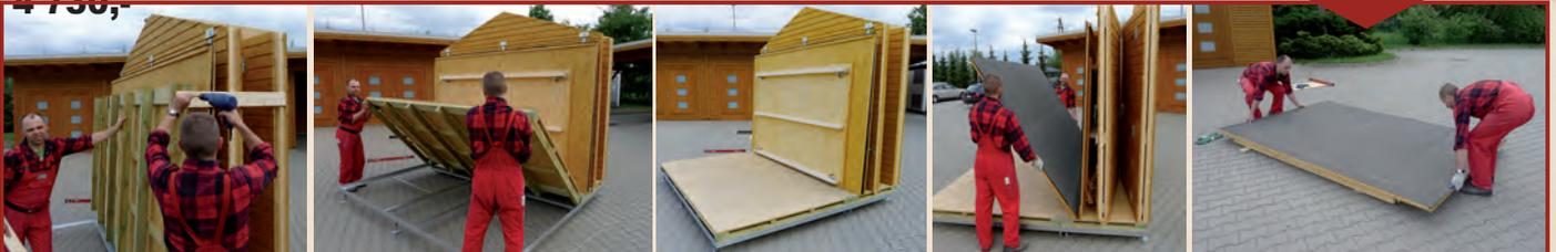
In Waage bringen und Boden ausklappen
