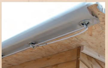
Plane über das Dach ziehen, mit den Ösen durch die Halter (Dachunterseite) befestigen und mit dem Seil sichern. - Blenden montieren - Fertig!
