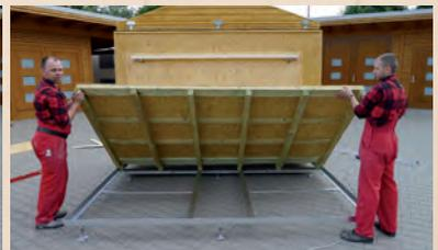
Auslegen und Einrichten des Grundrahmens - das Haus in den Grundrahmen setzen, zweiten Rahmen anmontieren und ausrichten. Fertig!
