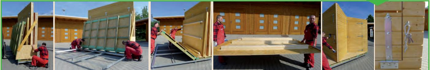
In Waage bringen und Boden ausklappen
