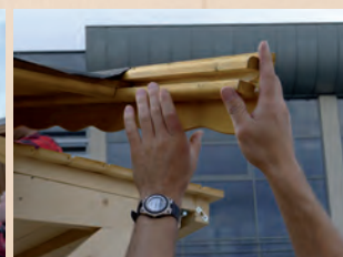
Dachelemente auflegen und verriegeln
