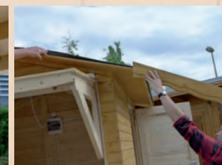
Verkaufsladen öffnen, Dachblenden anstecken
