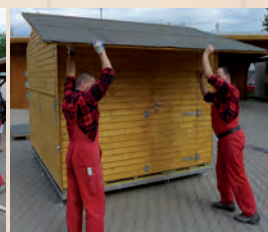
Dachelemente auflegen und verriegeln
