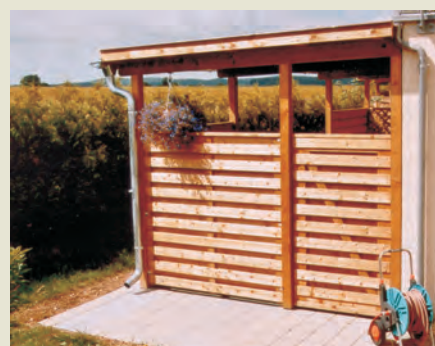
Sichtschutz Nr. 32 B zwischen den Pfosten in Lasur "Kastanien" getaucht
