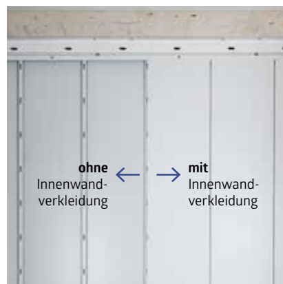
24 Innenverkleidung/ 25 Isolierung für Gerätehaus Neo (unsichtbar)
