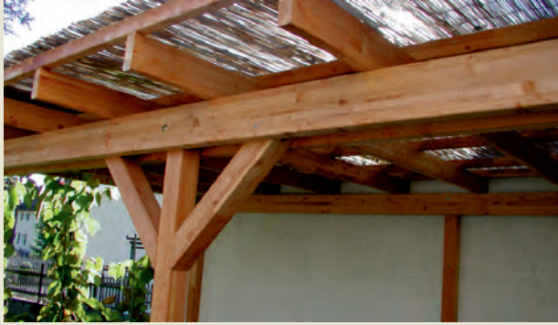
Länge 400 cm, Leimholz Lärche, keilgezinkt
