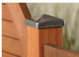
Konstruktiver Holzschutz: Schützen Sie die schichtverleimten Hartholzpfeiler zwingend mit Kappen aus Edelstahl, Seite 93.
