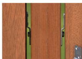
Befestigen Sie die Elemente mit Edelstahl-Elementhaltern für die verdeckte Verschraubung, Seite 93.
