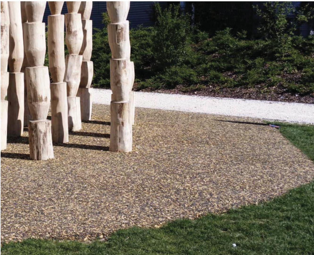
Die Tragschicht muss stand- und trittfest verdichtet sein. Wir empfehlen für die Trennung von Untergrund und Belag das Unkrautvlies «Plantex Pro».
