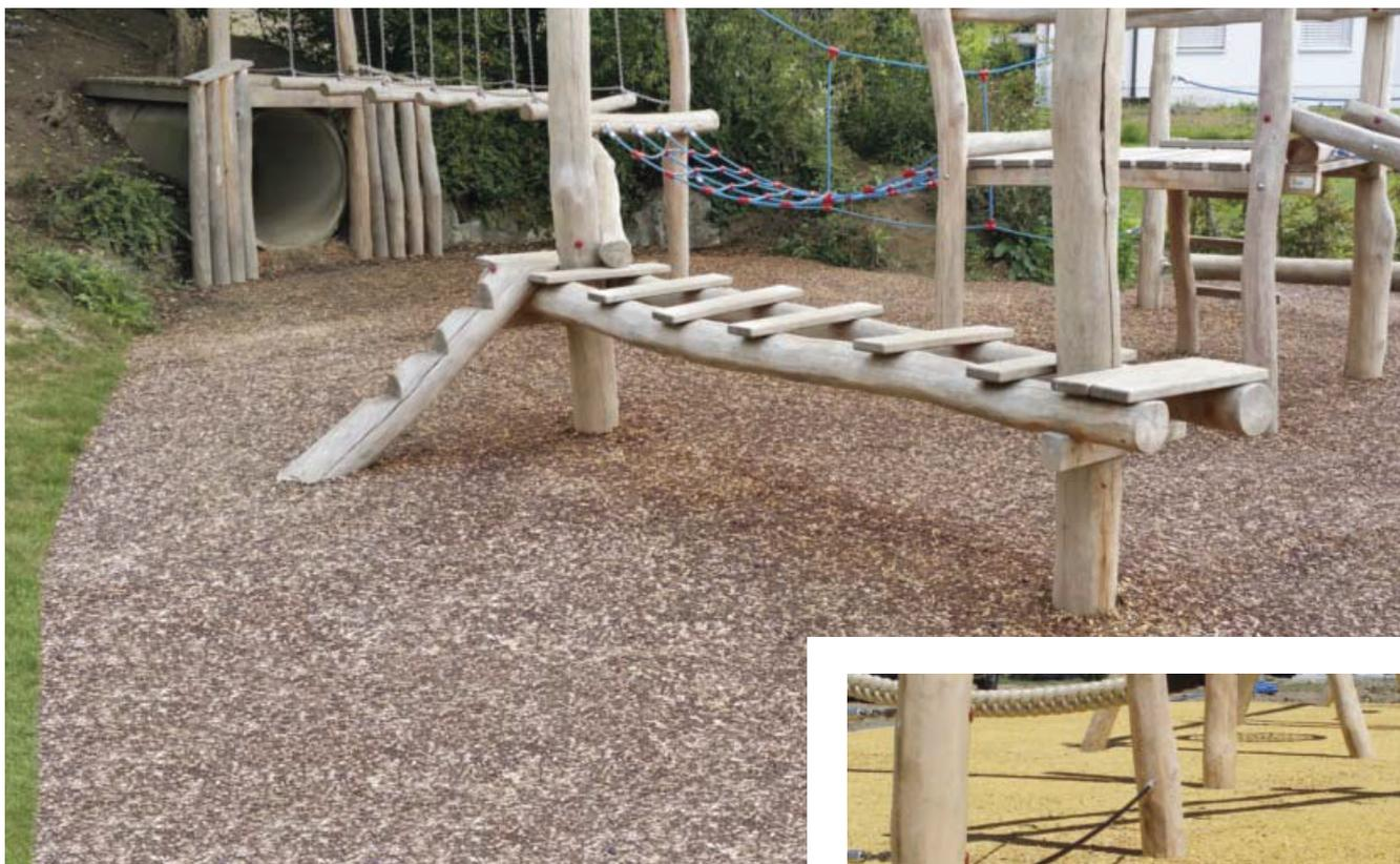
Mit einem Bindemittel werden die Gummischnitzel zu einem festen, fugenlosen Fallschutzbelag mit natürlicher Optik verarbeitet. Mit entsprechenden Geräten und Fachwissen kann der Belag selbst eingebaut werden.
