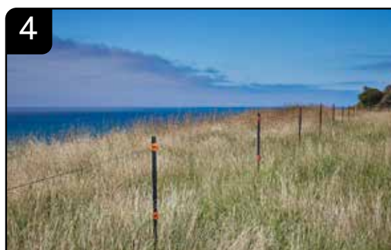
Stellen Sie die Zwischenpfähle auf
