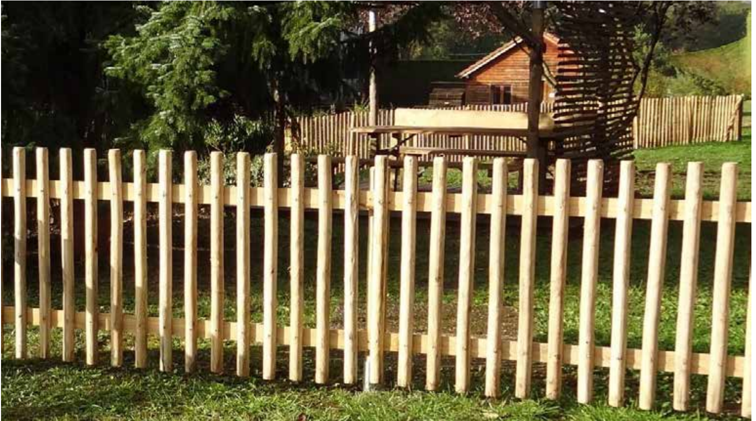
Latten aus Kastanienholz gefräst, Spitze gefast, Stärke ca. 24 mm, Breite 50 mm, Lattenabstand ca. 5 cm.
