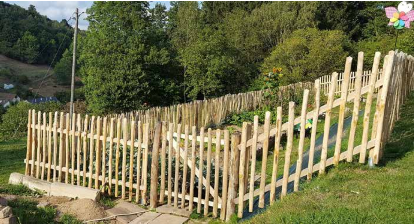
Der Lattenzaun aus halbierten, naturgewachsenen Latten mit abgeschrägter Spitze.
