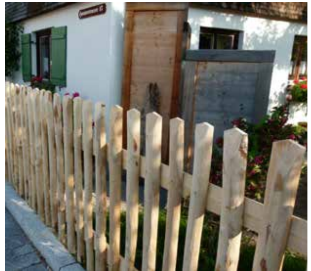
Der Lattenzaun aus halbierten, naturgewachsenen Latten mit abgeschrägter Spitze.
