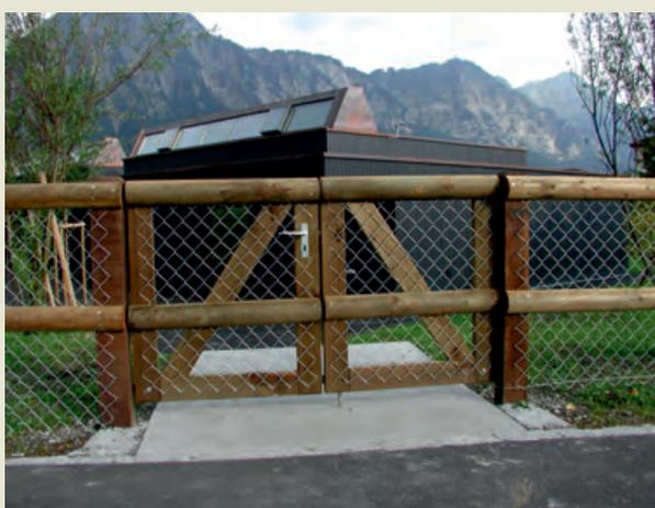
Holzkonstruktion **ausgeblattet** und verschraubt mit INOX. Schlossbrett mit Schloss und Schlüssel. Feuerverzinkte Bänder und verstellbare Kloben. Verkleidung mit Halbroundlatten. Festeler mit Bodenhülse. **ohne Pfosten**, ohne Montage.
