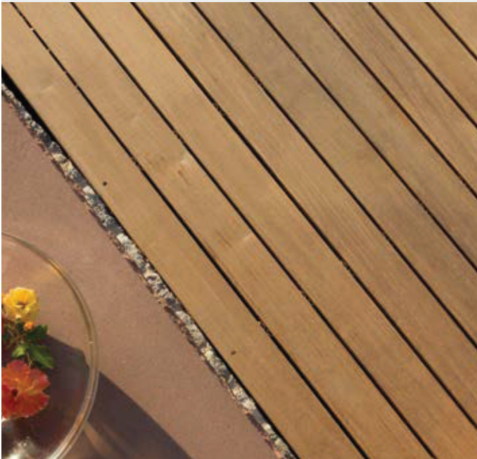
Abb.: mit pigmentiertem Hartholz-Pflegeöl behandelt
