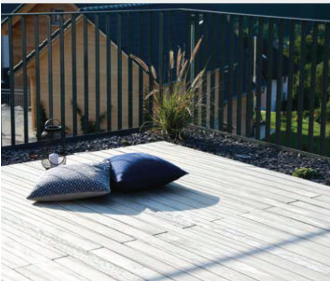
Abb.: unbehandelt, silbergraue Patina durch UV-Einstrahlung
