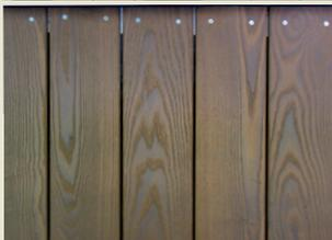
Bei sichtbarer Verschraubung müssen die Bretter vorgebohrt und die Schraubenköpfe bündig versenkt werden. (auch bei der Verwendung von Schrauben mit Bohrspitzen).
