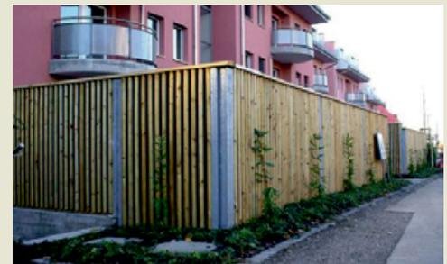
Lärmschutzwand aus stabilen Elementen zwischen einbetonierten H-Eisenträger versetzt, vorgefertigte Elemente: Rückseite Nut/Federschalung und absorbierende Seite Halblatten 5,5 cm (auf Abstand) in verschiedenen Oberflächenstrukturen, dazwischen kaschierte Mineral-Schallschluckplatte. Pfostenabstand bis 400 cm, Schalldämmung ca. 33 dB
