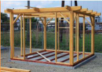
Skelettkonstruktion
