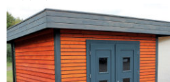
Flachdach (mit Dachüberstand)
