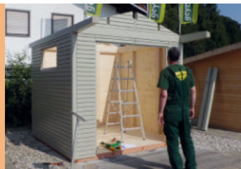
Einsetzen der fertig montierten Wand- und Giebelelemente
