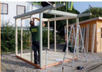
Aufbau der Skelettstruktur
