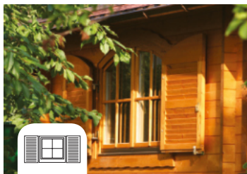
Fenster mit o. ohne Klappläden
