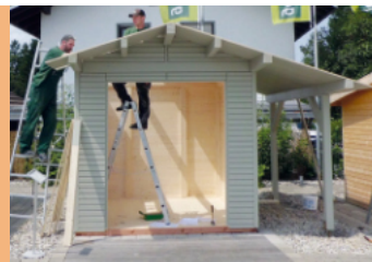
Erstellung der Dachschalung
