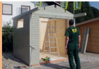
Einsetzen der fertig montierten Wand- und Giebelelemente
