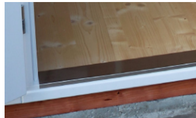
Türschwellen mit Edelstahlabdeckung oder mit Aluschwelle optional möglich
