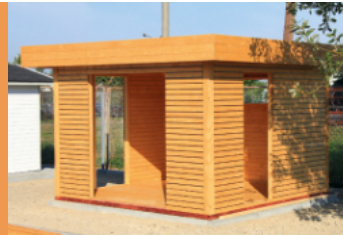
Dach- und Wandschalung
