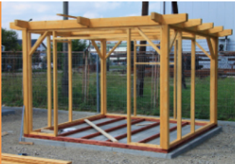
Skelettkonstruktion
