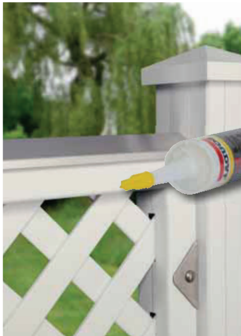
Designaufsatz Alu mit MS-Polymer-Kleber (1398) befestigen.
