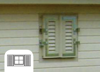
Fenster mit o. ohne Klappläden
