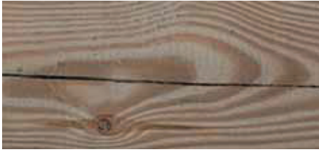
Spannungsrisse durch die Holz Trocknung
