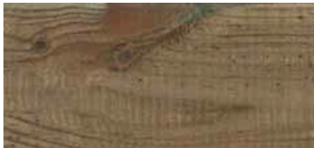
Raue Stellen auf der Holzoberfläche
