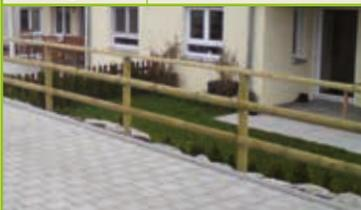
Pfähle KDI\* zylindrisch gefräst, Kopfende gefast
