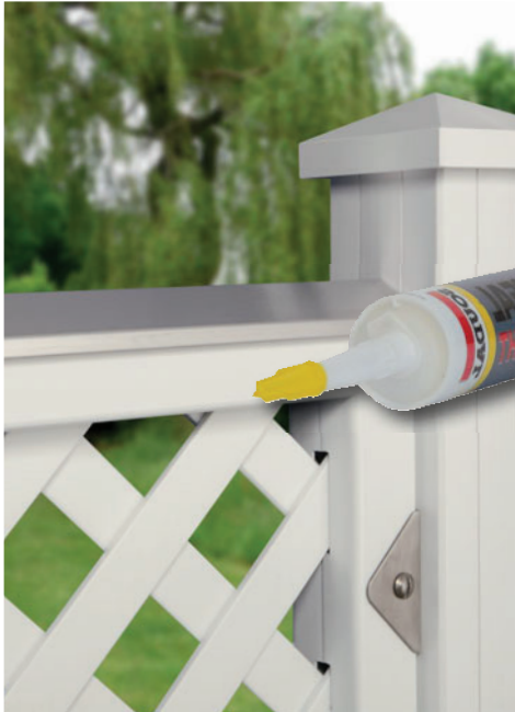
Designaufsatz Alu mit MS-Polymer-Kleber (1398) befestigen.
