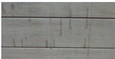
Fleckenbildung durch von Regen angelöste Partikel
