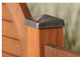
Konstruktiver Holzschutz: Schützen Sie die schichtverleimten Hartholzpfeosten zwingend mit Kappen aus Edelstahl, Seite 119.
