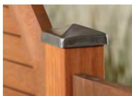
Konstruktiver Holzschutz: Schützen Sie die schichtverleimten Hartholzpfeosten zwingend mit Kappen aus Edelstahl, Seite 119.
