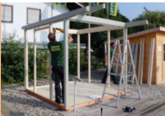
Aufbau der Skelettstruktur
