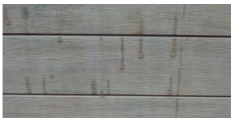
Fleckenbildung durch von Regen angelöste Partikel
